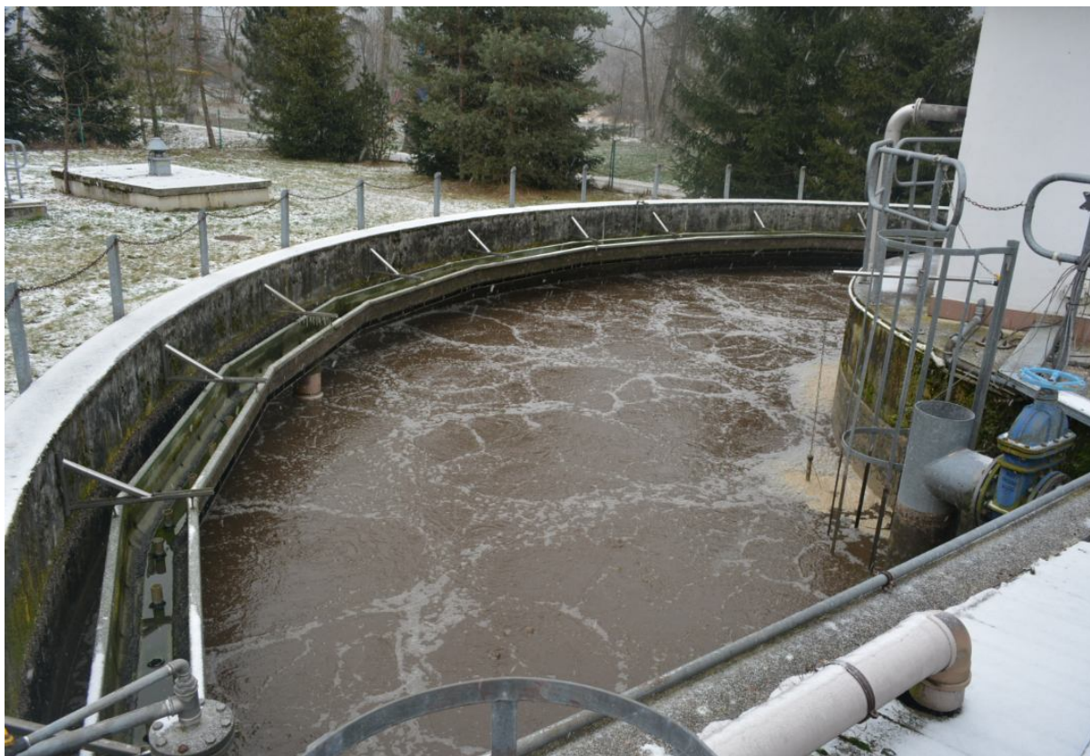
Rysunek 11 Widok na funkcjonujący reaktor biologiczny zlokalizowany przy stacji dmuchaw, [foto: Paweł Kręciproch]
